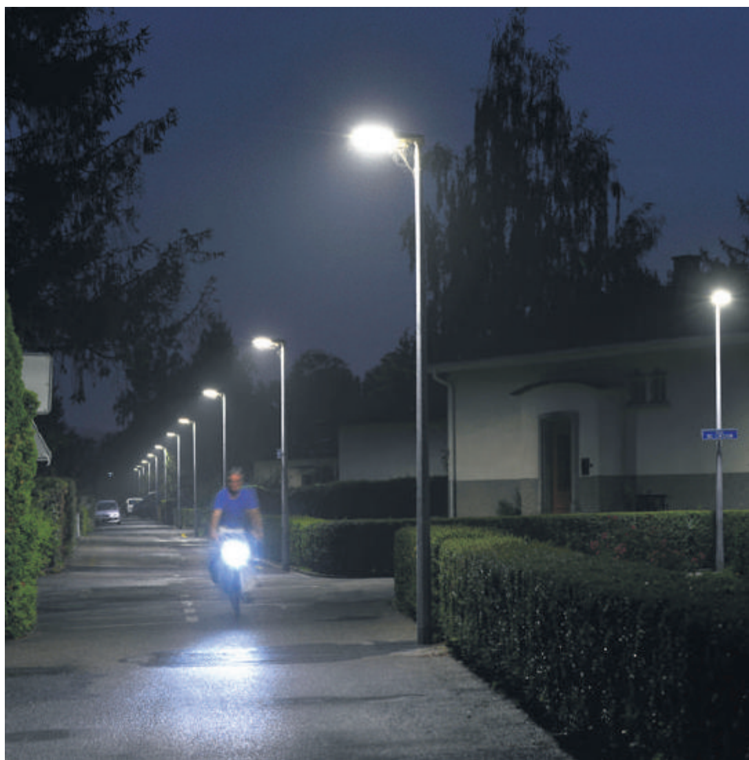
L'éclairage dynamique varie d'intensité au gré des passages, comme ici à Yverdon. CHRISTIAN BRUN
