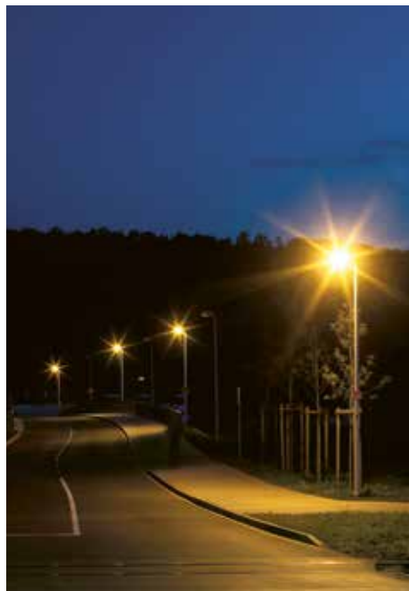
Si un luminaire sur deux est éteint, le cycliste disparaît dans la zone sombre. Photo: Trilux GmbH
